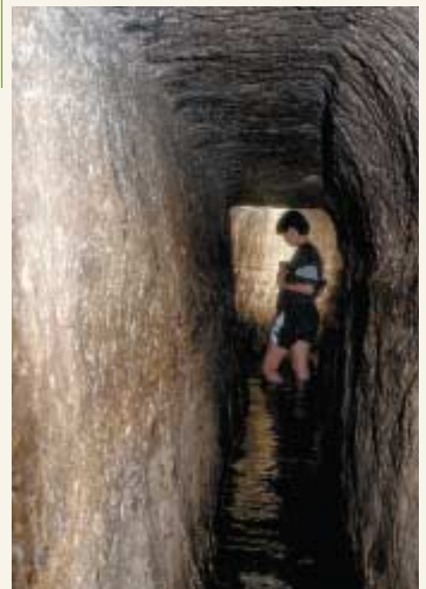
Die Bauarbeiter des Königs Hiskia vollbrachten eine großartige Leistung, als sie einen langen Tunnel (rechts) durch den Kalkstein unter Jerusalem aushieben, um rechtzeitig vor einem Angriff der Assyrer die Wasserversorgung der Stadt zu sichern. Die Inschrift erzählt, wie die Arbeiter, aus beiden Richtungen kommend, den Durchbruch herstellten.
